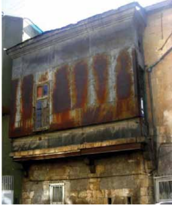
Resim 9: Kepkep Sokağına açılan 127 nolu parseldeki evin sokağına taşma yapan üzeri saç kaplı çıkması (G. Gül, 2010)
